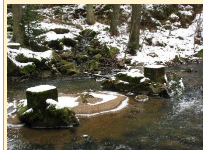
Betonové opěry posledního z přemostění Haldy u Pochopovy skály (pod tunelem B).
