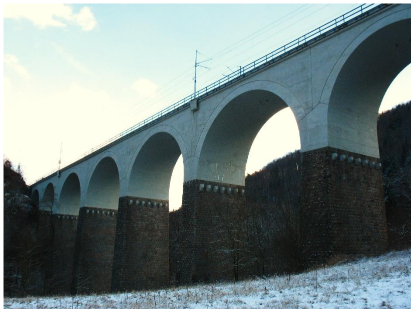
Vlevo: železniční viadukt v Mezihorí. Délka 180m max. výška 38m, betonové pilíře obkládané bosovaným kamenem, horní část železobeton. Obrázek nahoře: Zbytky základů vrátku na terase v úrovni tišnovského portálu tunelu, asi 30m jižně od něj (č.4 na mapce)
