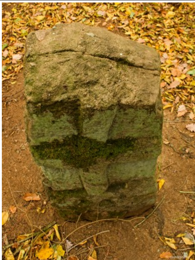
Pohled shora ukazuje výraznou puklinu
